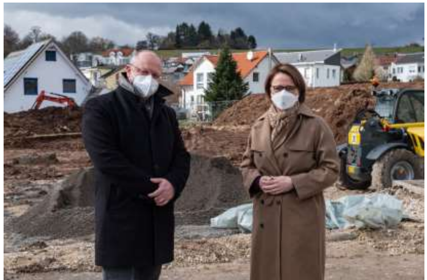
Bürgermeister Engesser und Staatsministerin Widmann-Mauz vor der Baustelle des neuen Kindergartens in Dettenhausen.
